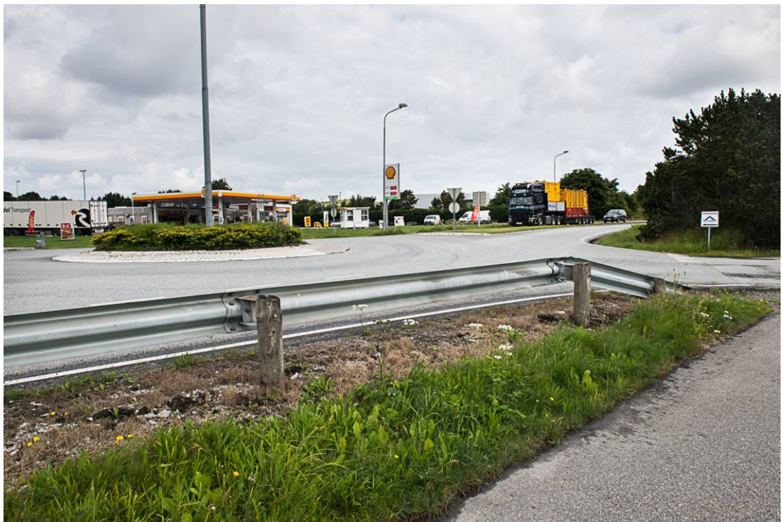
Figur 33. Foto fra påkjørselsområdet HTU_3.
