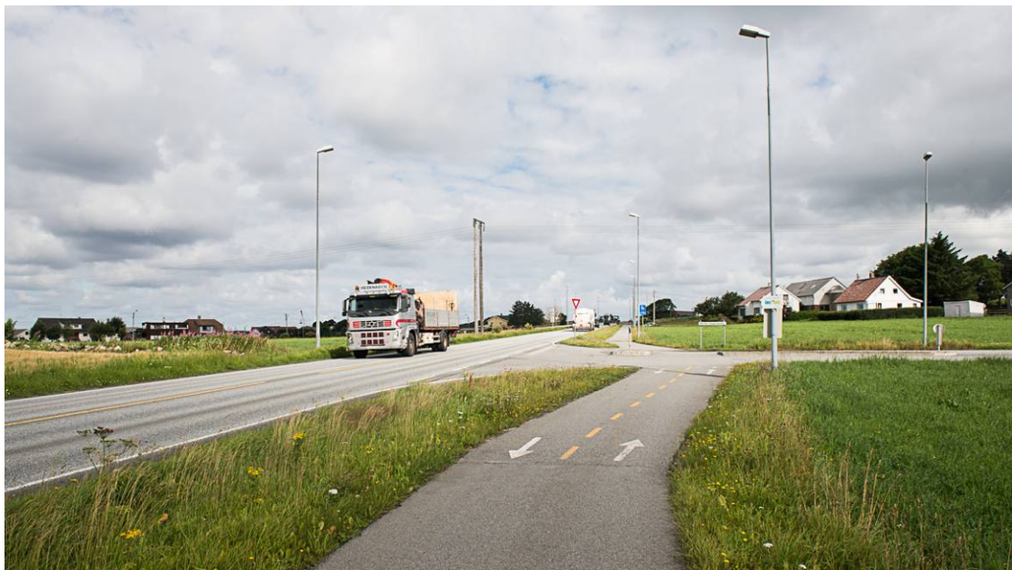
Figur 29. Foto fra påkjørselsområdet HTU_1.
