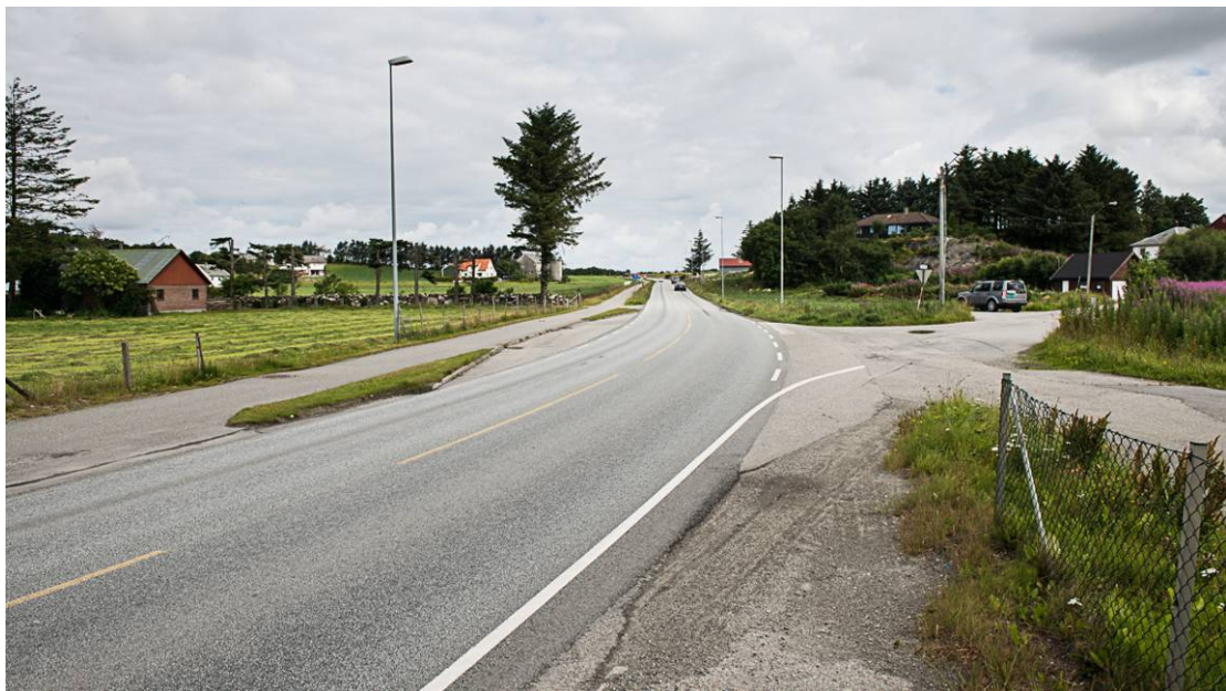
Figur 35. Foto fra påkjørselsområdet HTU_4.
