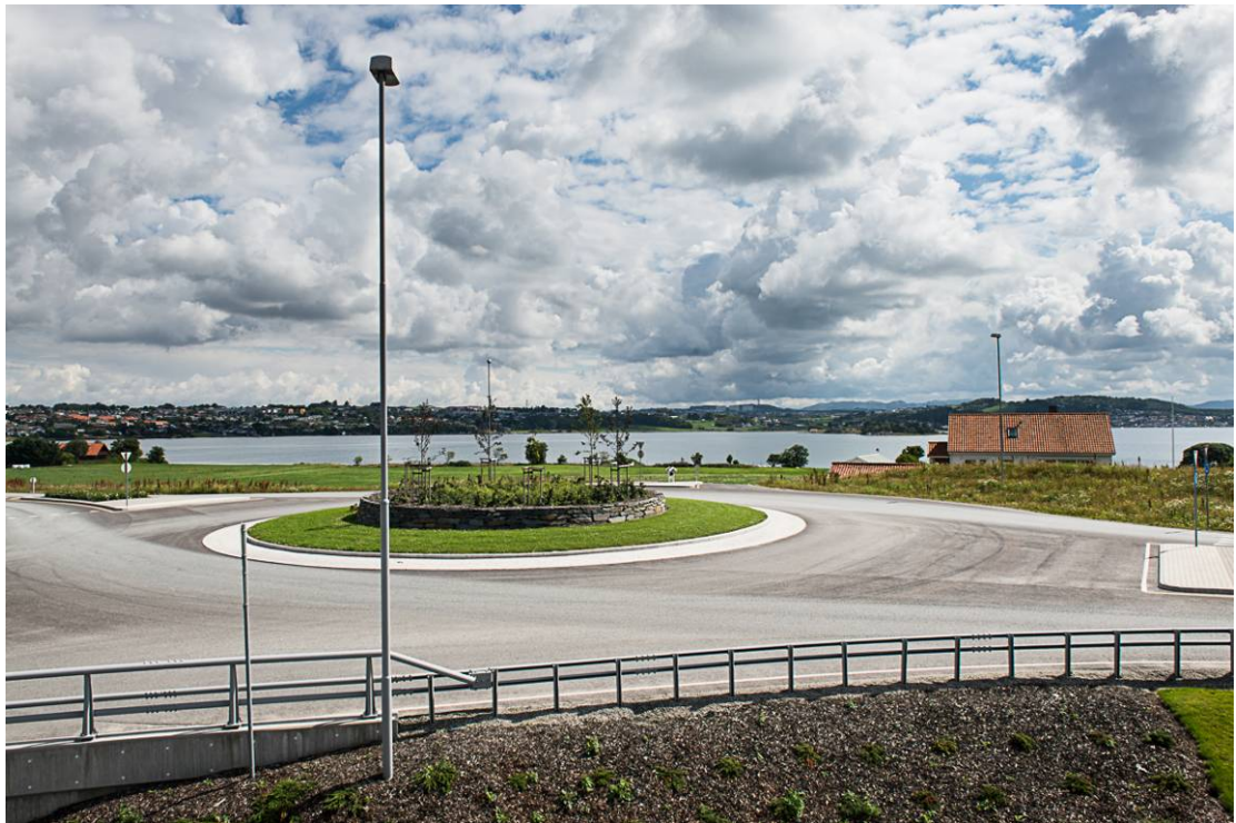
Figur 39. Foto fra påkjørselsområdet HTU_6.
