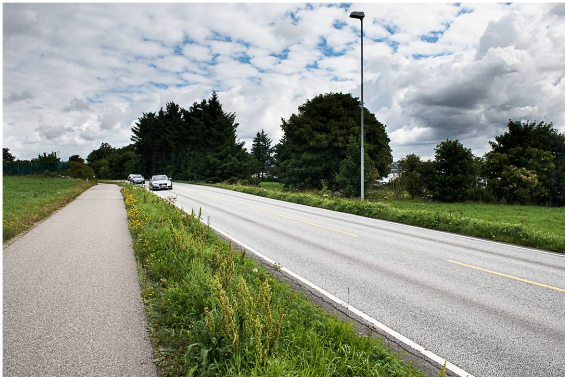
Figur 37. Foto fra påkjørselsområdet HTU_5.
