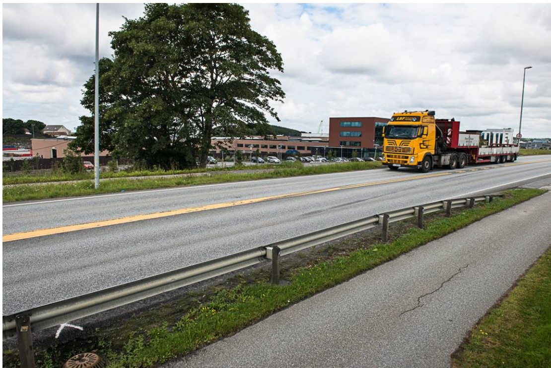
Figur 31. Foto fra påkjørselsområdet HTU_2.
